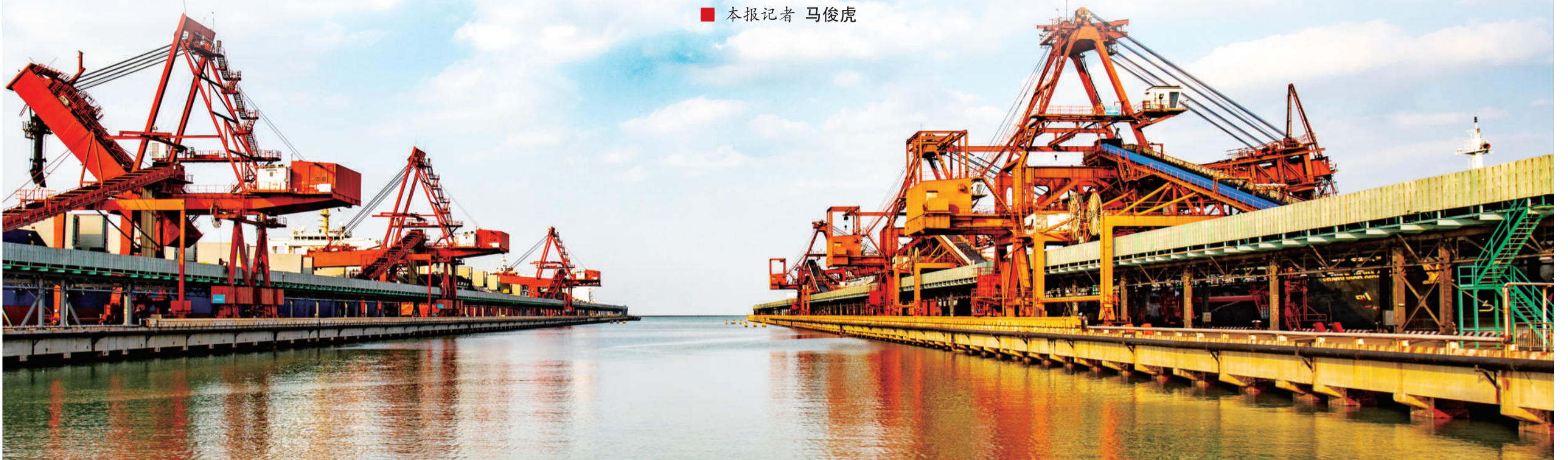
煤港码头卸船机一字排开，蔚为壮观。
