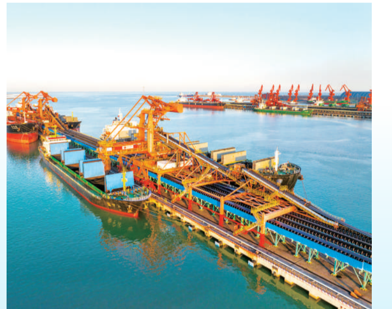
2020年4月,黄骅港打通了智能化作业的最后一个环节——装船机智能化作业,填补了世界散货港口自动化装船作业的技术空白,具备完全自主产权。图为港口公司黄骅港务煤炭码头正在进行煤炭装船作业。
