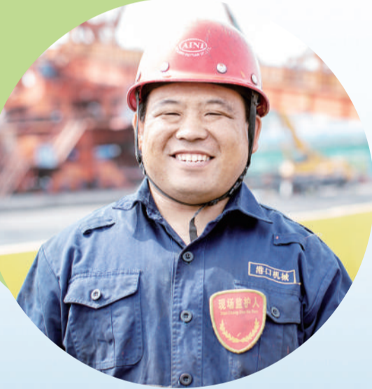
港口公司黄骅港务外委维修人员在堆场维修作业。
