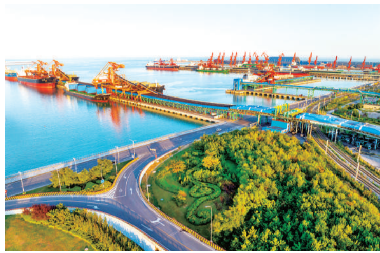
港口公司黄骅港务码头全景。
