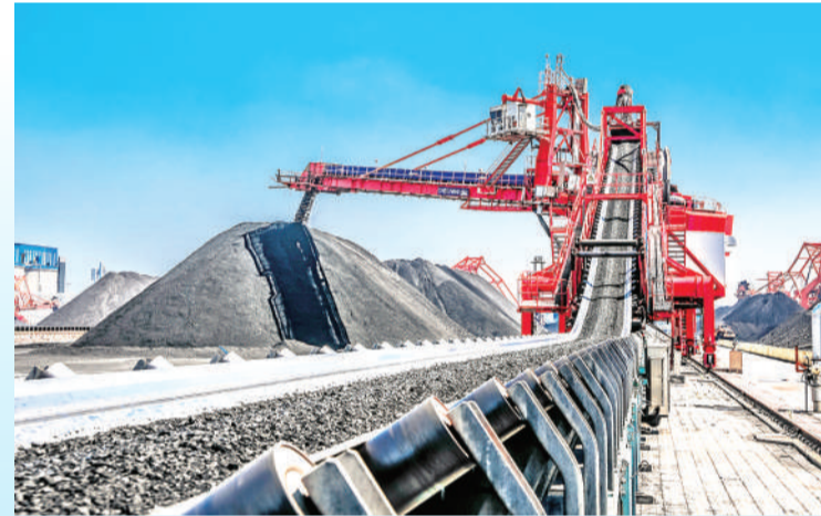
黄骅港煤炭港区开发出一套绿色生态管控平台系统,实现应用水系统智能管控。通过对水资源的科学利用,黄骅港建立闭环绿色环保机制目标,实现煤尘和煤污水近零排放。图为港口公司黄骅港务堆料机正在进行堆料作业。
