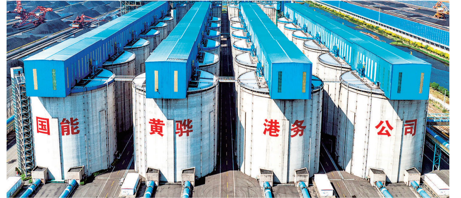
港口公司黄骅港务储煤筒仓群是世界最大,也是目前国内工艺最先进、效率最高的煤炭装卸系统。48座筒仓总储煤量达144万吨,相较于传统堆场堆存工艺,筒仓采用全封闭设计,从源头上隔绝了煤炭粉尘外溢,作业效率更是露天堆存的2倍。自2017年达产以来,筒仓煤炭年周转量超亿吨,员工仅有142人,人均效率在业界遥遥领先。
