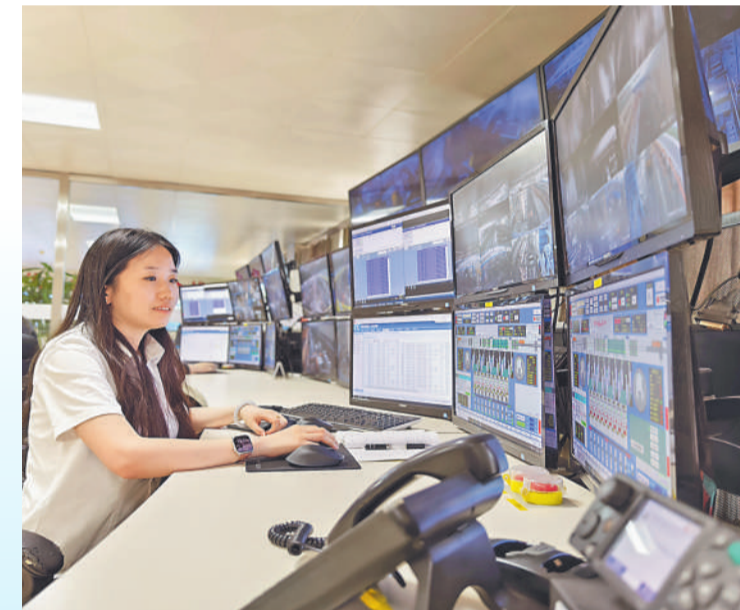
得益于智能化建设的不断探索,黄骅港成为世界上首个实现翻车机全流程智能化的煤炭港口。一艘5万吨级的运煤船,大约24小时就可以完成装卸货,且全流程无需人工操作。图为港口公司黄骅港务三期集控室员工在远程监控翻车机自动作业。
