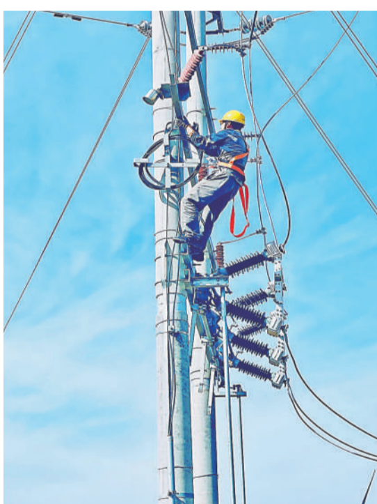
技术人员在高空紧固绝缘瓷瓶螺栓。
