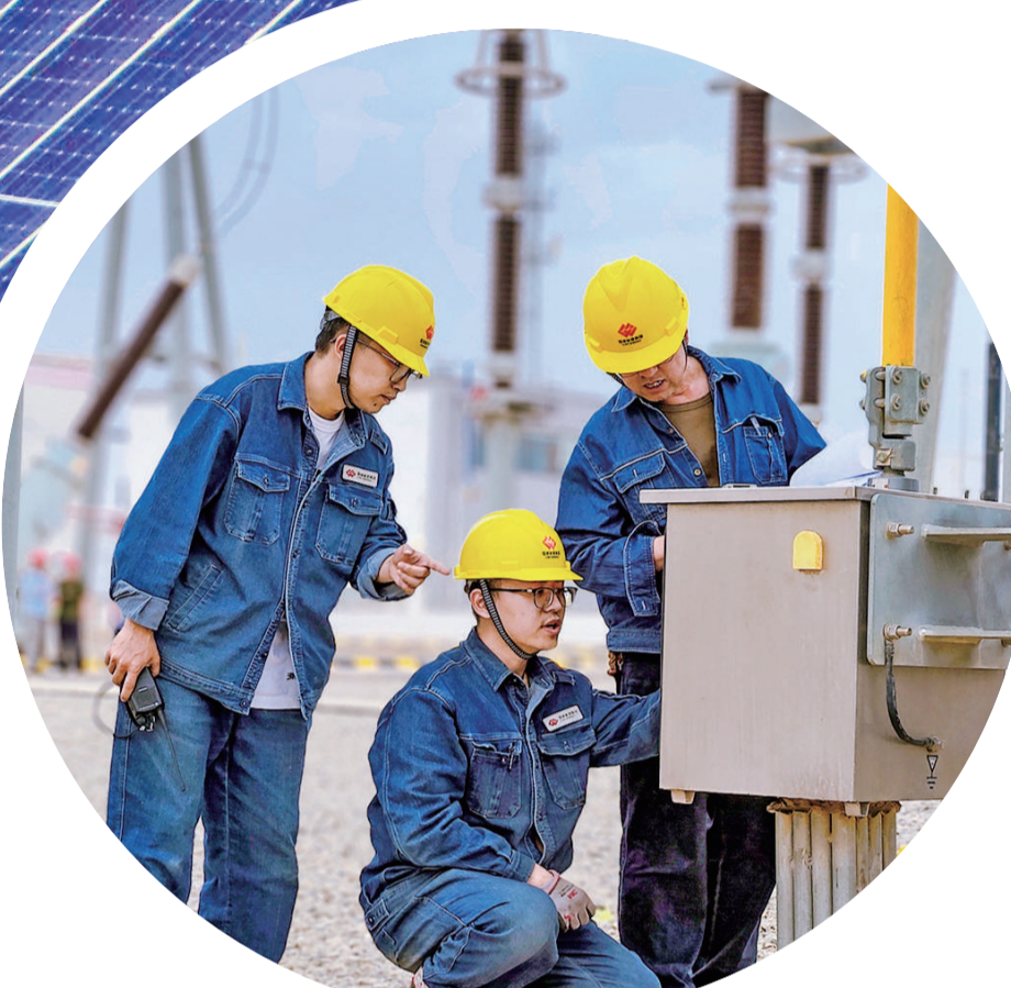
酒泉风电场巡检员对升压站设备定期检查。
