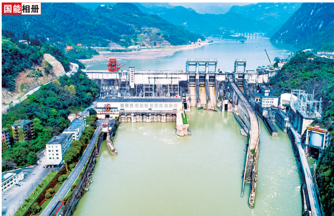
5月10日，大渡河公司在北京电力交易中心绿色电力消费核算应用平台完成绿电消费数据信息登记。经核算，2023年度累计交易绿证700张，绿电70万千瓦时，实现电站办公区域100%绿电消费，以实际行动支持了新疆等省份光伏项目发展、绿电政策落地，为打造绿色国家能源品牌作出积极贡献。图为大渡河龚嘴水电站。
