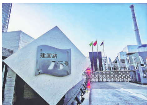
坐落在北京市朝阳区建国路75号的国家电力北京热电厂。
