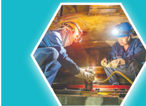
检修人员正在进行机组检修。
