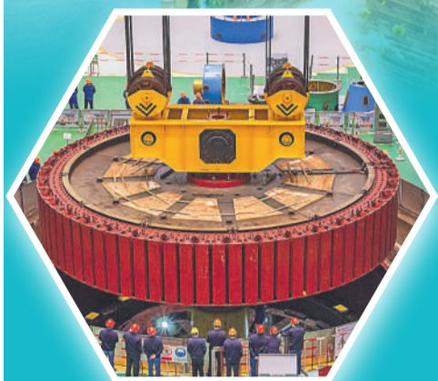
起吊水轮发电机转子。
