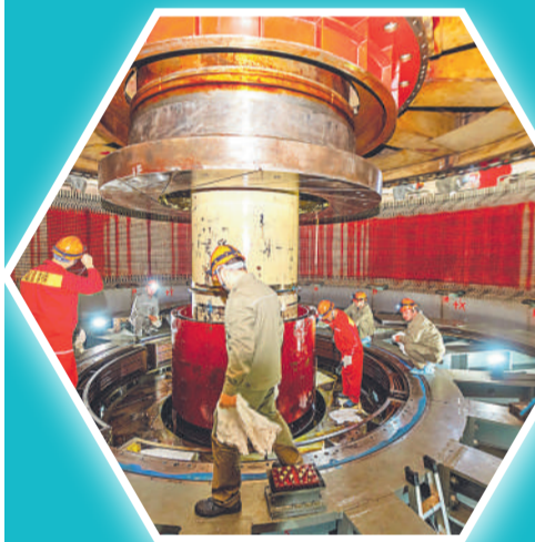
检修人员正在检查推力及轴承承情况。
