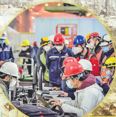
该公司党员带头在现场调试机组设备。
