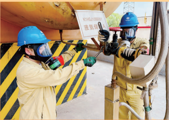
6月28日，国电电力绥中公司开展液氨泄漏应急演练，进一步检验氨区重大危险源管控措施落实情况。图为检修人员对泄漏点缺陷进行抢修。通讯员 尹嘉兴 摄
