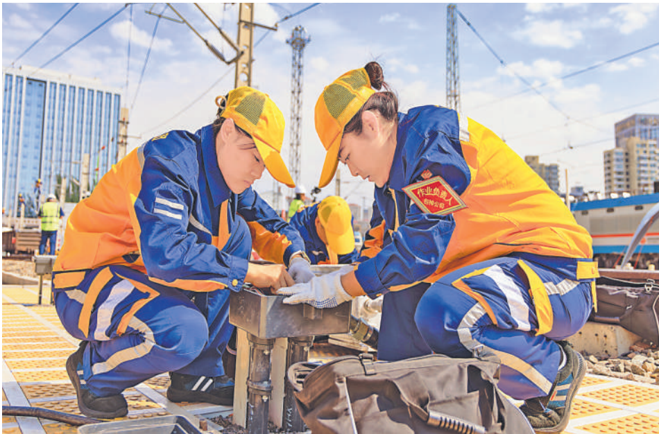
▲针对近期持续出现的高温、降雨天气给信号设备运行造成的不良影响，7月1日，包神铁路东胜站区组织管内电务专业对信号设备开展专项排查整治，确保迎峰度夏期间设备运行稳定。图为女工正在对道岔转辙机进行检查。 通讯员 李尚昆 摄
