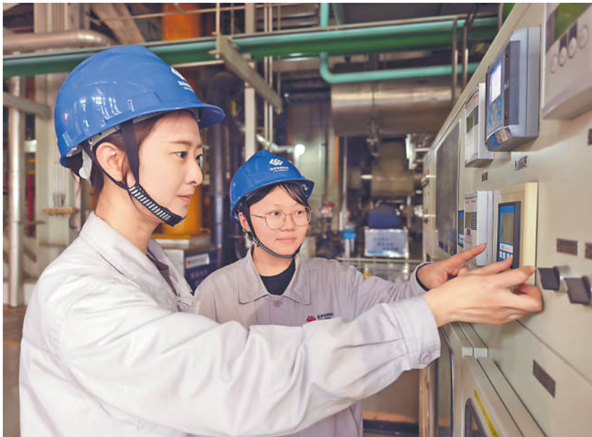
▲近日，河北公司沧东电厂对重点仪表设备进行拉网式清查，确保仪表阀门开关稳定，仪表测量数据精准，为安全生产提供有力保障。图为女工正在检查精处理系统仪表设备。 通讯员 邓志恒 摄
