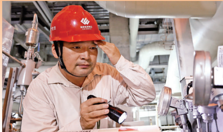
清远电厂工程技术人员进行现场表计检查。通讯员 胡艺贤 摄
