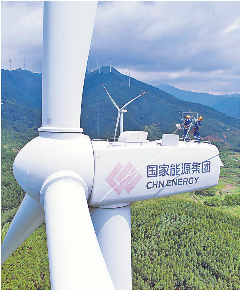
湖南新能源公司飞龙风电场运检人员在风机上检查风机风速仪。 罗善清 摄
