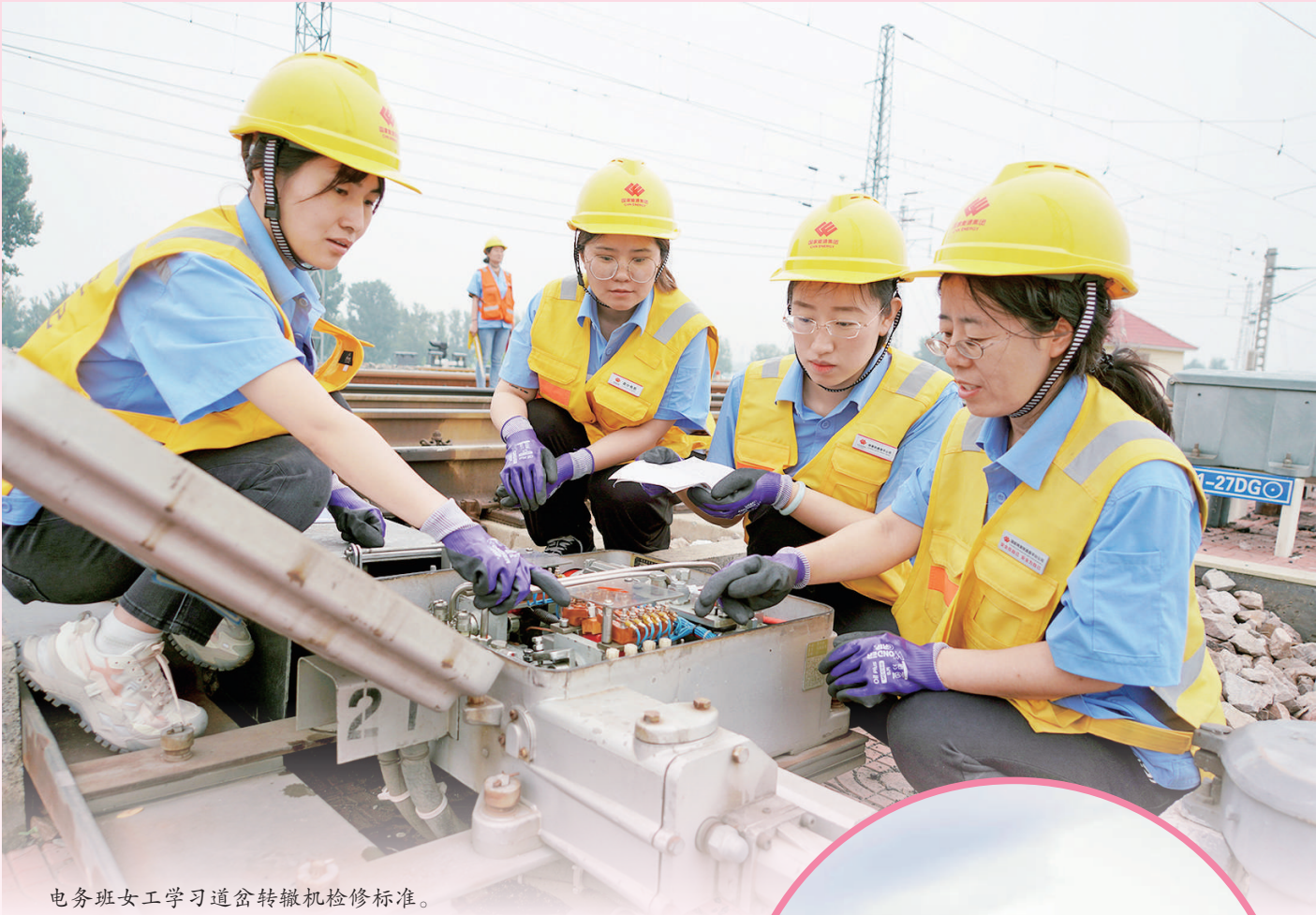
电务班女工学习道岔转辙机检修标准。
