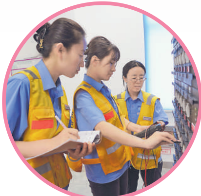
电务班女工正在测试区间设备电压。
