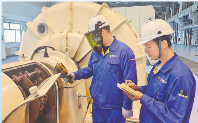
▲ 7月12日,乌鲁木齐地区气温持续攀升,新疆化工加大直流系统、发电机等关键设备巡检力度,防止设备“中暑”。图为员工测量发电机运行温度。
