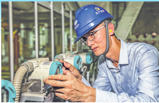
▲ 7月14日,福建石狮公司检修人员顶着39摄氏度的高温,挥汗如雨检修压力变送器,全力保障机组安全稳定运行。
