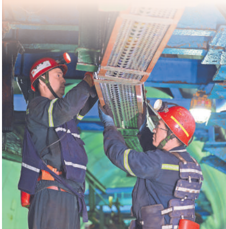
检修工对架空乘人装置进行安全确认。 通讯员 张凯 摄
