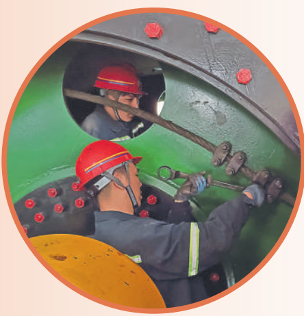
检修人员开展钢丝绳紧固工作。 通讯员 慕宾宾 摄
