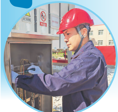
王成林正在检修端子箱加热器。 通讯员 杨宇辰 摄
