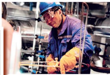
7月20日,新疆化工年度消缺检修工作正在如火如荼地进行。面对持续高温天气,检修人员坚守在检修一线,高质量完成一项项检修任务。图为检修人员正在加热给水泵汽轮机螺栓。
