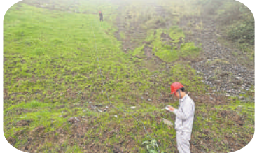
现场人员进行边坡复绿验收工作。 通讯员 向洋秋 摄
