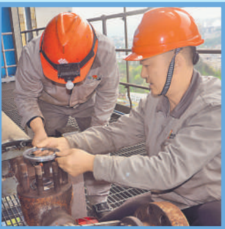
汽机班成员攻关解决1号锅炉再热器减温调整阀导向筒破裂检修难题。
