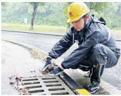
重庆万州电厂及时排查生产现场安全隐患，提升设备防汛能力，有力保障电力安全稳定供应。图为7月29日，运行人员清理排水沟杂物。 通讯员 赵宁宁 摄
