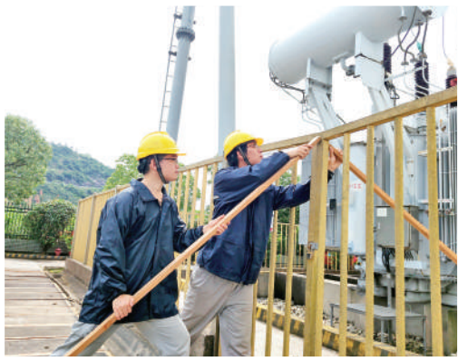
龙源电力浙江公司提高特巡频次，加快应急抢修速度，确保9个集中场站和近50个分布式光伏电站安全稳定高效运行。图为工作人员对场内设施进行二次加固。 通讯员 刘武运 摄
