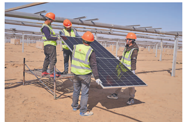
在国电电力鄂尔多斯采煤沉陷区综合能源基地内，国能人顶着烈日，互相配合，井然有序地拼接太阳能板，将绿色清洁电能送到千家万户。
