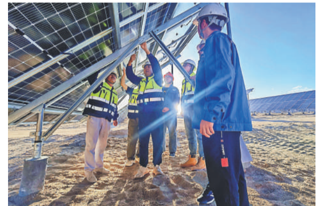
在青海公司大柴旦100万千瓦“风光储”项目施工现场，施工队伍与建设单位紧密合作，仔细检查着每一块光伏组件搭建情况。
