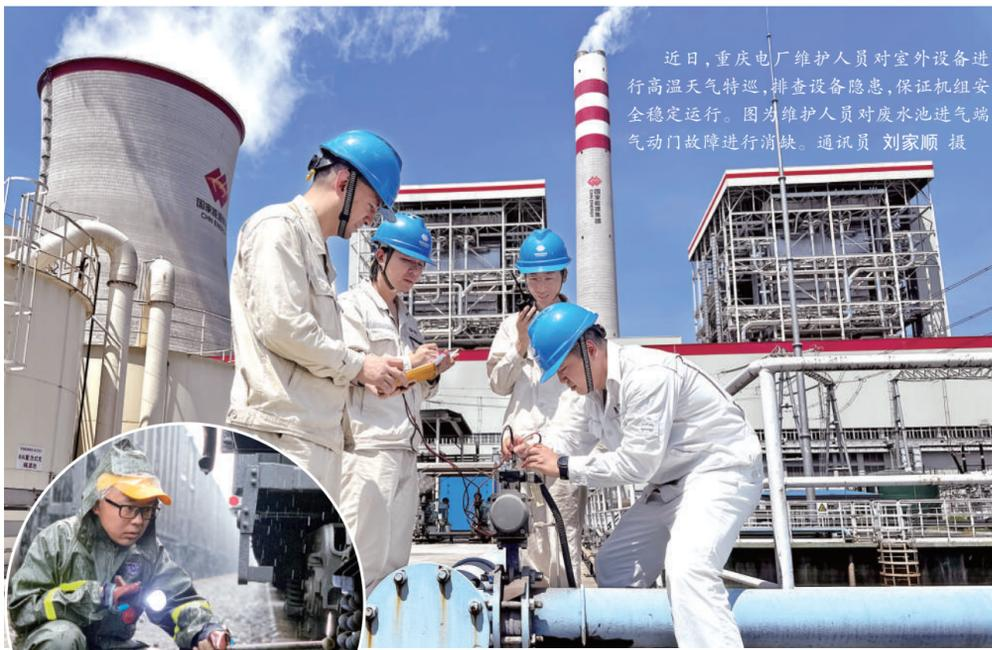
近日，重庆电厂维护人员对室外设备进行高温天气特巡，排查设备隐患，保证机组安全稳定运行。图为维护人员对废水池进气端气阀门故障进行消缺。通讯员 刘家顺 摄
