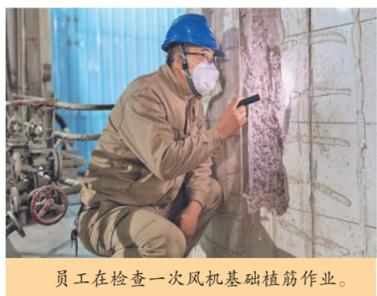
员工在检查一次风机基础植筋作业。
