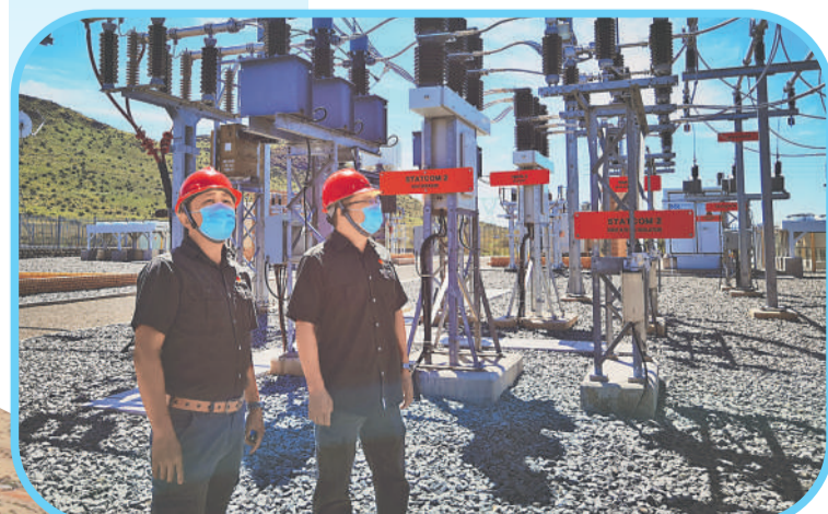
龙源南非德阿项目员工在巡检设备。
