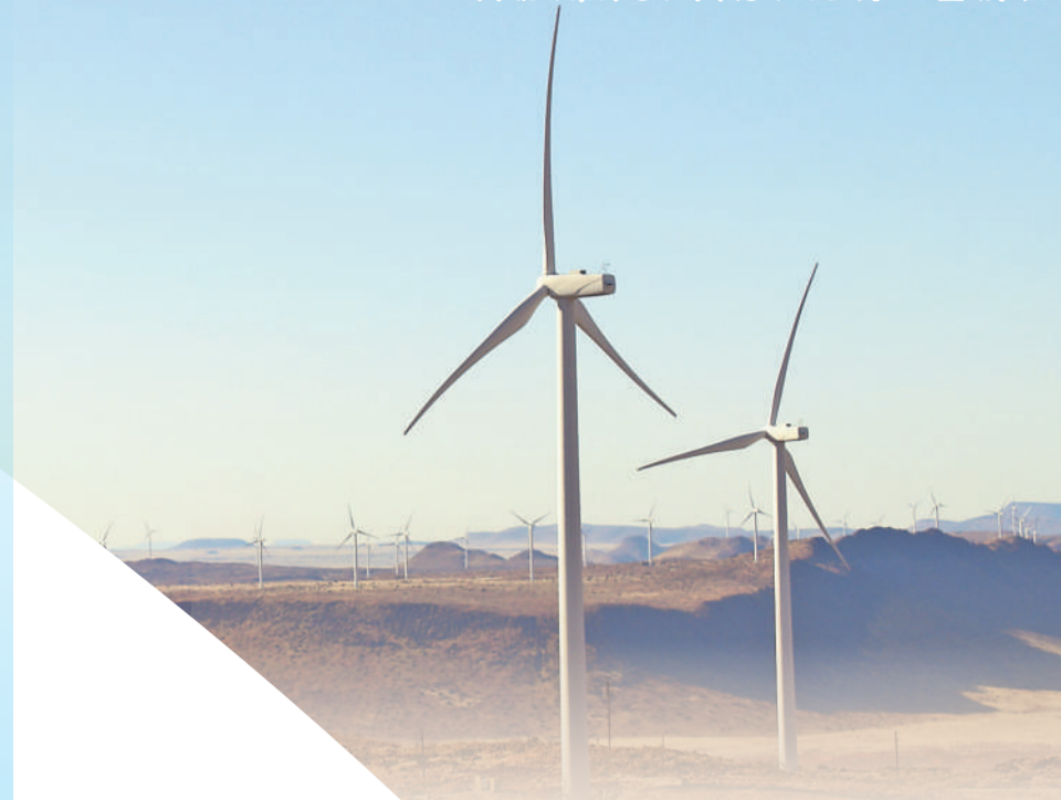
国家能源集团龙源南非德阿风电场。 盛斌 摄
