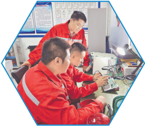
创新工作室成员正在修复故障继电器。 通讯员 向南 摄
