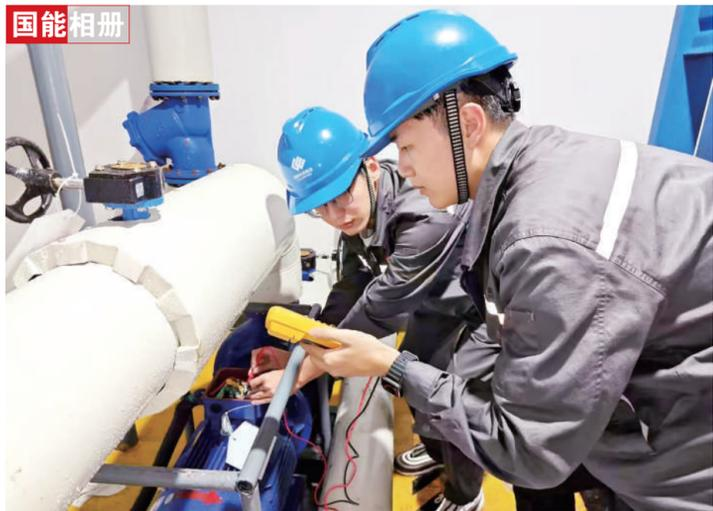
近日,宁夏电力供热公司开展电机专项检查,排除设备安全隐患,确保供热系统稳定运行,保障区域居民温暖过冬。图为运维人员检查电机电压。 通讯员 李欣 摄
