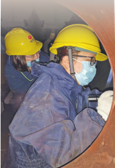
化验女工在C修期间检查汽包内部腐蚀情况。 通讯员 陈燕 摄
