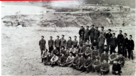
经过连续奋战，江厦潮汐电站配套建设的库区大坝成功合龙。图为合龙后部分建设人员合影。
