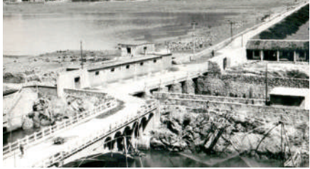
潮汐电站配套建设的泄水闸完成改造，采用液压启闭机操作，实现调节水库水位功能，满足电站双向发电需要。
