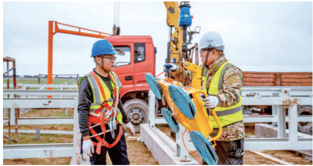
▲ 工作人员正在搭建光伏模块拼装工棚。
