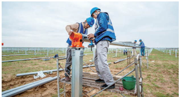
▲ 建设者在紧固平单轴螺栓。
