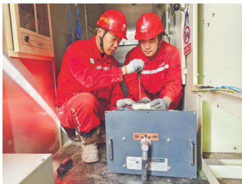
11月以来,内蒙古准格尔地区气温持续下降,准能集团黑岱沟露天煤矿加大对采场高压供电设备防寒防冻日常维护与隐患排查,为四季度煤炭生产提供可靠电力保障。图为11月6日维修工正在修复真空断路器。
