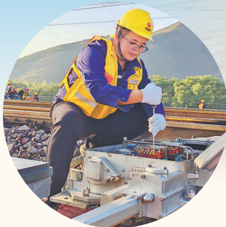
赵杰在天窗点内检修道岔设备。
