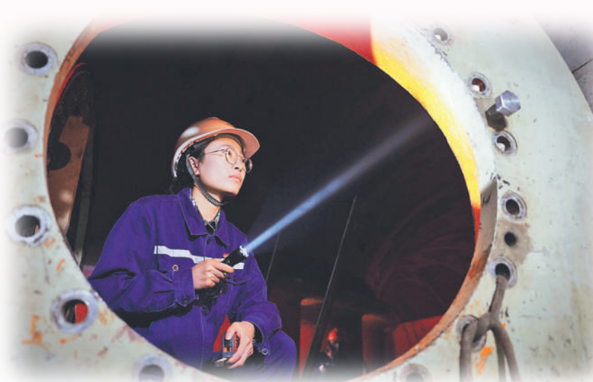
童玉英正在蜗壳进入门处检查蜗壳流道。 通讯员 张海轩 摄
