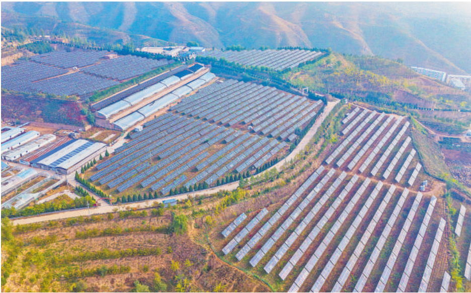
国家能源集团投资建设的吴堡县前庙山村光伏电站维修扩容200千伏项目，该项目是移民搬迁后续帮扶产业，总投资210万元，每年可实现利润30万元。
