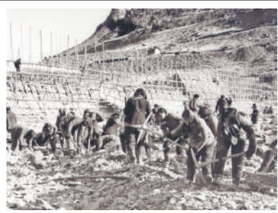
桓仁水电站早期建设场景。
