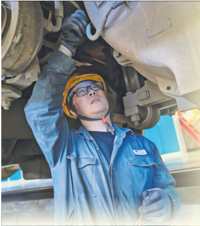
12月6日,新朔铁路机务公司机车检修工对机车牵引电机进行防寒检查和保养,提升机车设备质量,为迎峰度冬能源保供提供保障。 通讯员 曾繁飞 摄
