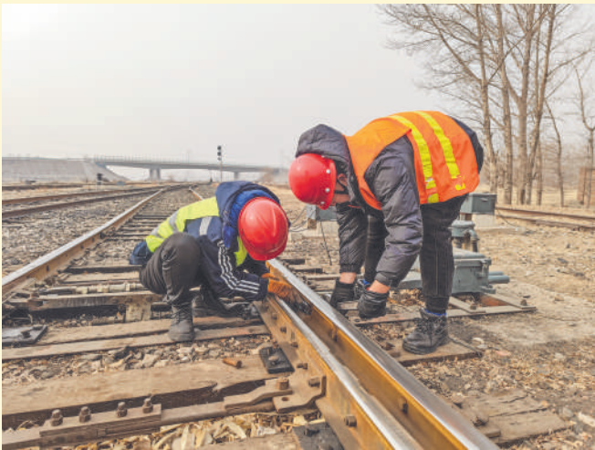
针对连日来的寒潮低温天气,平庄煤业运输公司检修人员全面做好机车防寒保养、线路信号道岔巡检养护工作,畅通运输通道,确保能源稳定供应。 通讯员 乔立宇 摄
