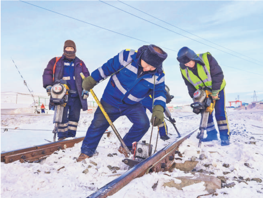
▲针对近期呼伦贝尔地区寒潮、降雪天气，日前，雁宝能源铁路运输中心工务段进行起道捣固作业，进一步提高煤炭运输线路安全水平，确保煤炭安全稳定供应。图为职工进行线路捣固作业。
