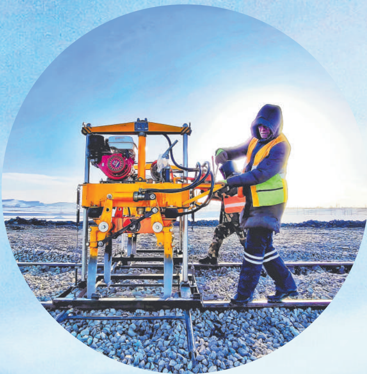
闫辉(左)、王志强推着捣固机向故障路段行进。
