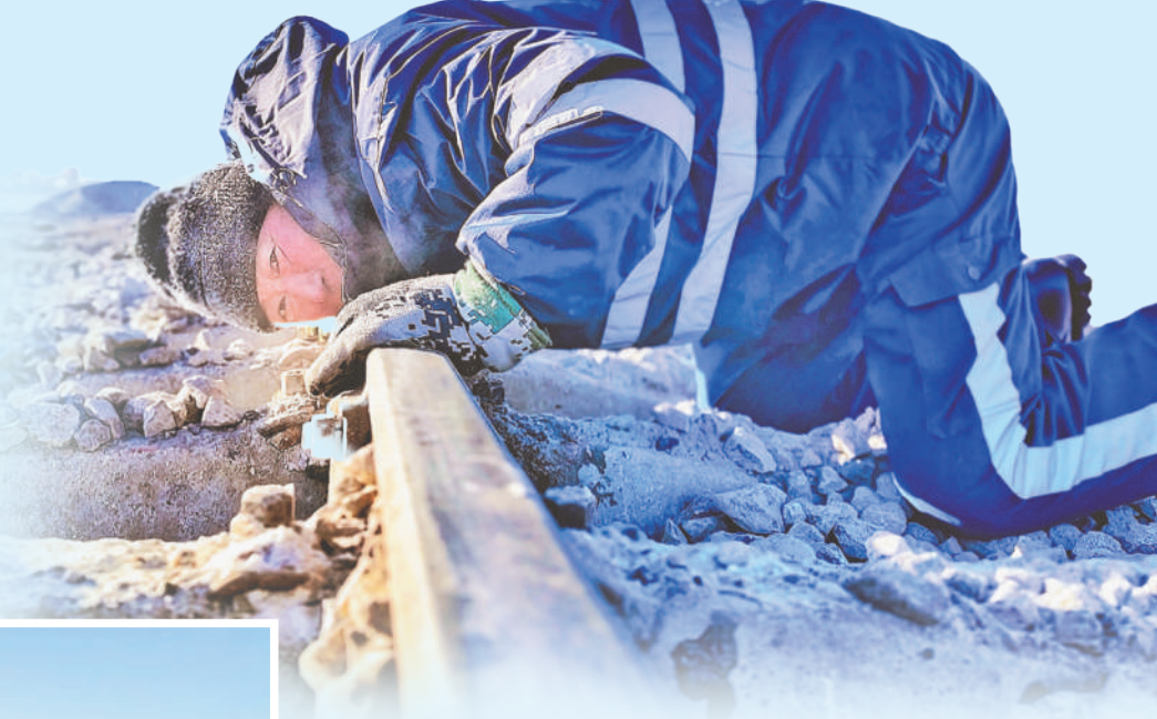
趴在冰冷的铁轨上,潘凤君目测线路水平高低。
