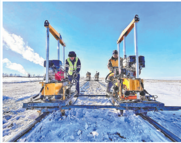
自如驾驶捣固机,贾国玉(右)、迁长林开始捣固道床恢复轨距。
