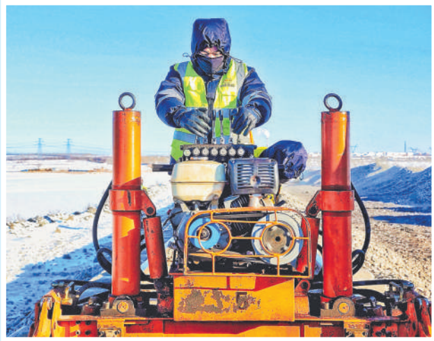
张晓明全神贯注进行线路起道作业。
