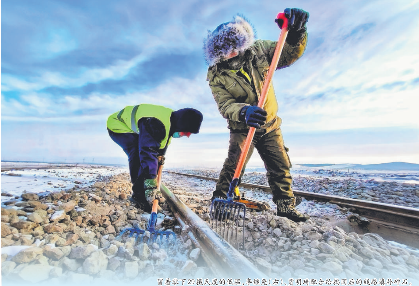
冒着零下29摄氏度的低温,李继尧(右)、贾明琦配合给捣固后的线路填补碎石。
