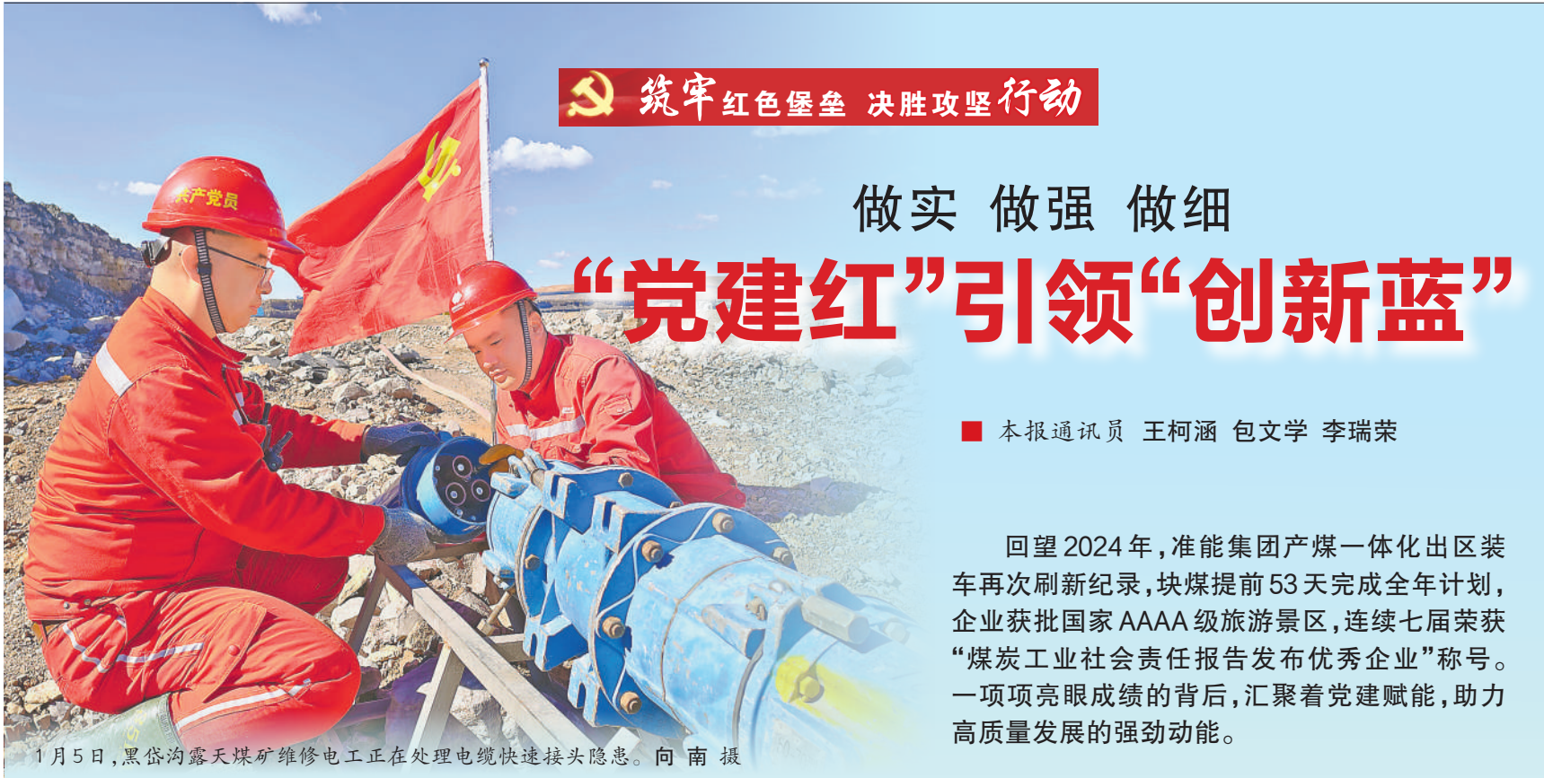
1月5日,黑岱沟露天煤矿维修电工正在处理电缆快速接头隐患。向南摄
