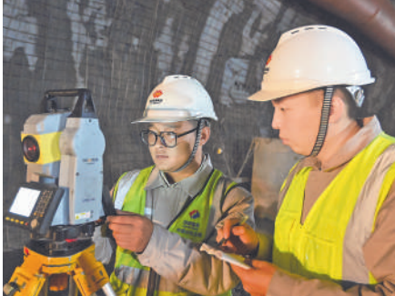
青年职工复核引水隧洞开挖数据。
