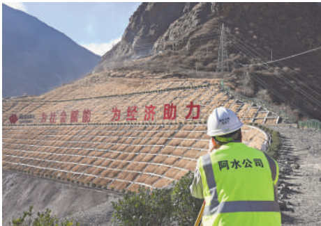
青年职工张诚排查厂房边坡地质隐患。
