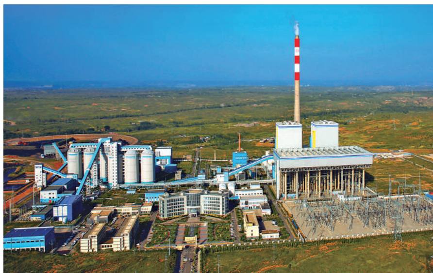
国电电力布连电厂2号机组是国内首次应用全国产IDCS技术的煤电机组。图为该电厂全景图。通讯员 刘阅兵 摄
