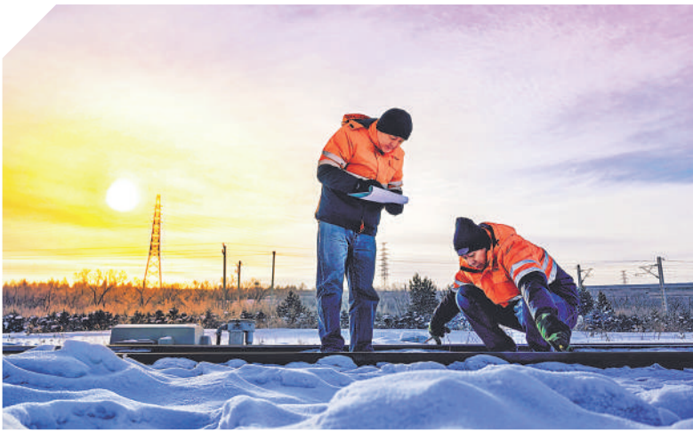
信号维修班工作人员正在测量轨道电路。 通讯员 王国丰 摄
