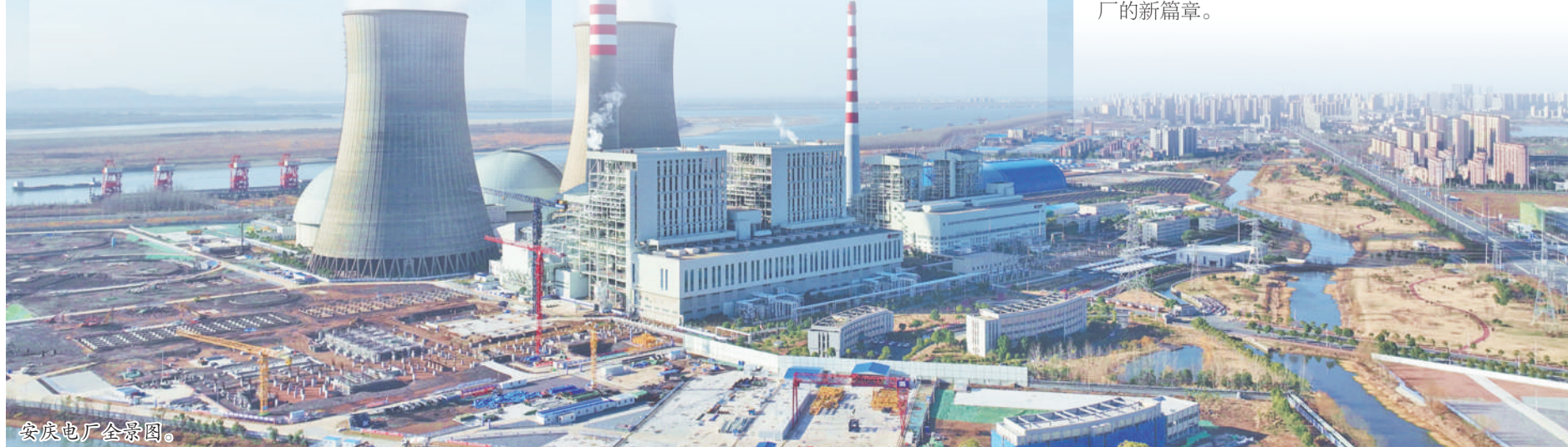
安庆电厂全景图。
