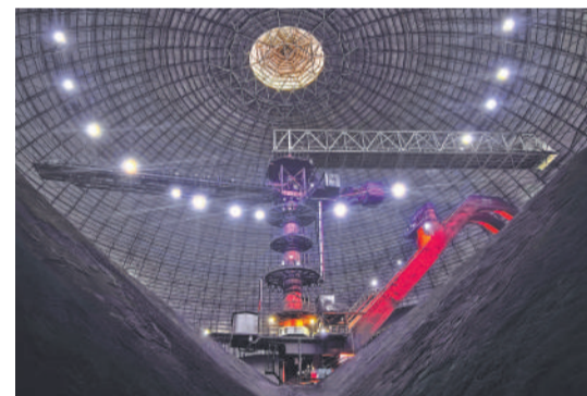
球形煤场无人堆取料机正在运行。
