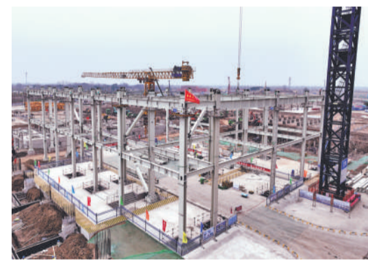
安庆三期5号锅炉钢架安装现场。
