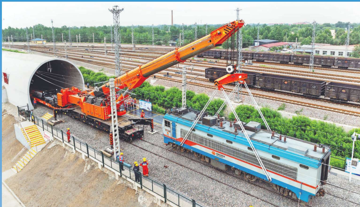
6月5日，在迎峰度夏百日会战拉开序幕之际，朔黄铁路本着“贴近实战、注重实效”原则，在河北肃宁、山西原平、山东东营三地同步开展防汛抢险应急救援实战演练，全面检验朔黄铁路应急救援体系的科学性、规范性，持续强化应急队伍快速响应、协同作战和现场的处置能力，为确保国家能源运输大通道安全畅通奠定良好基础。图为演练现场。
