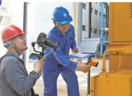
▲6月4日,山东费县公司新闻宣传人员崔耀中(左)在1号机组引风机站跟拍隐患排查全过程。该视频素材将制成安全生产月“隐患随手拍”活动示范案例,用于班组安全培训。 通讯员 刘纪征 摄
