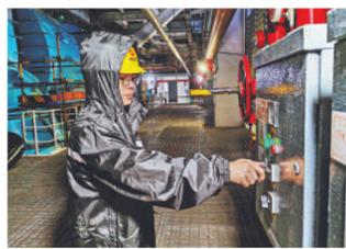
▲广东台山电厂加强燃料供应各环节设备巡检,通过干煤掺烧、煤种优化搭配等措施,精准保障台风期间机组“口粮”稳定供应,确保机组安全稳定运行。图为运行人员试运行凝汽器地坑排污水泵。 通讯员 王文成摄
