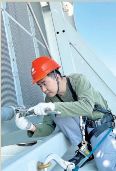
运检员正在机舱外检查水冷系统。
