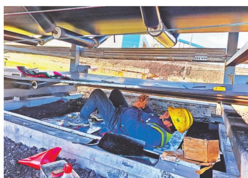
▲平庄煤业建公司锡林河项目部针对135皮带钢丝裸露隐患，采用高强度硫化工艺进行加固修复。通过优化硫化温度、压力及黏合技术，有效提升皮带接头的抗拉强度和耐磨性，确保皮带运输系统安全稳定运行。图为6月19日该公司运转工清除皮带裸露钢丝。通讯员 邹新才 摄
