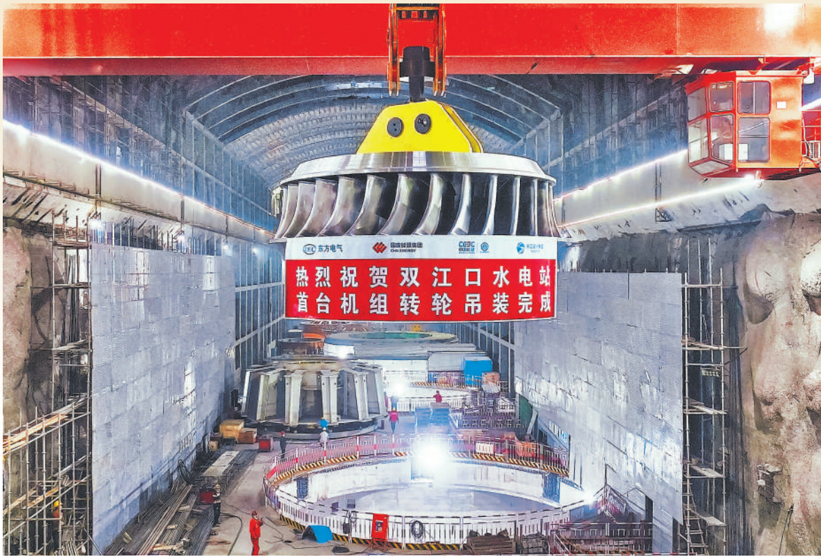
▲ 3月30日,作为国家西部大开发重点工程、国家和四川省“十四五”重点项目的大渡河公司双江口水电站地下厂房完成首台机组转轮吊装工作。通讯员 邓琛凯 摄
