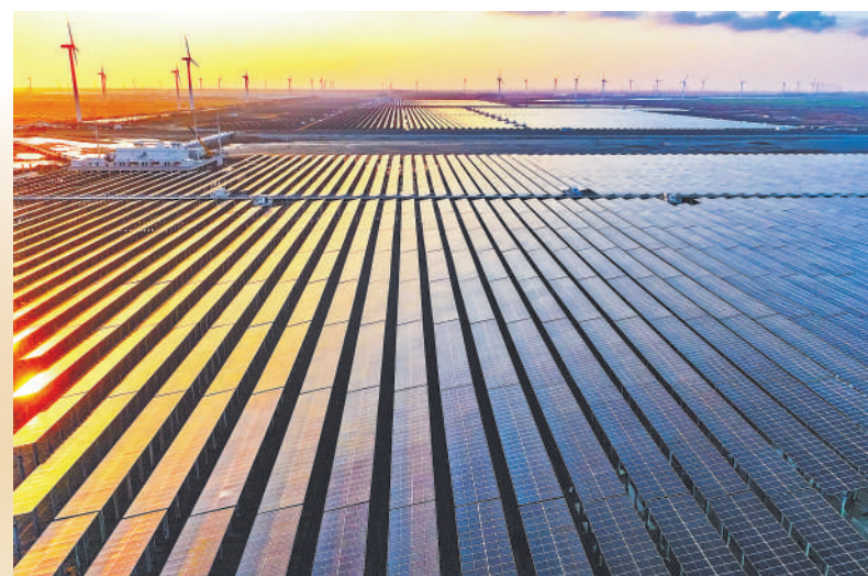
▲ 4月28日,国华投资江苏如东“光氢储一体化”项目实现全容量并网,以“光伏+治草+储能+制氢”模式,在4300亩滩涂构建能源生态系统。通讯员 柏成 摄
