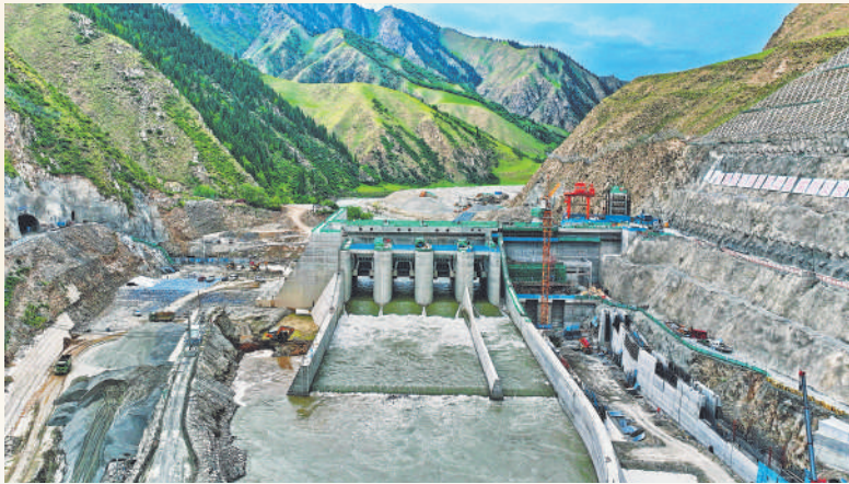
▲ 霍尔古吐电站是新疆维吾尔自治区及国家能源集团“十四五”重点项目,是开都河中游河段规划“两库七级”开发方案中的第三级电站,是国家能源集团在疆最大在建常规水电项目。该项目总装机容量426.5兆瓦,年发电量约16.2亿千瓦时。7月9日,该水电站主厂房安装间结构混凝土成功浇筑至1812米高程,标志着水电站主体工程建设取得阶段性进展。通讯员 米热德力·库尔班 摄
