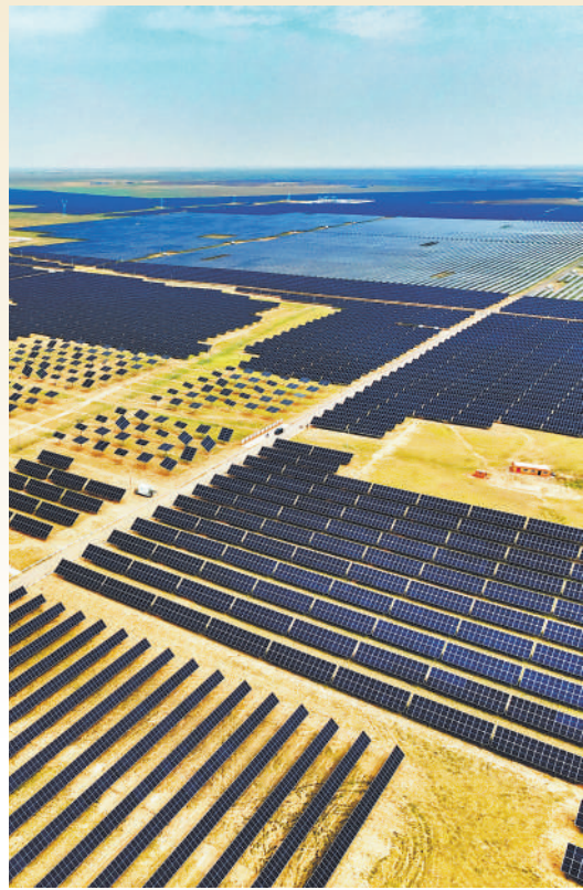
▲ 5月30日,国内首个“沙戈荒”气候区大型光伏实证示范基地在国电电力内蒙古综合能源蒙西蓝海光伏电站正式投用,填补了国内“沙戈荒”光伏技术实证领域空白。通讯员 梁哲睿 摄
