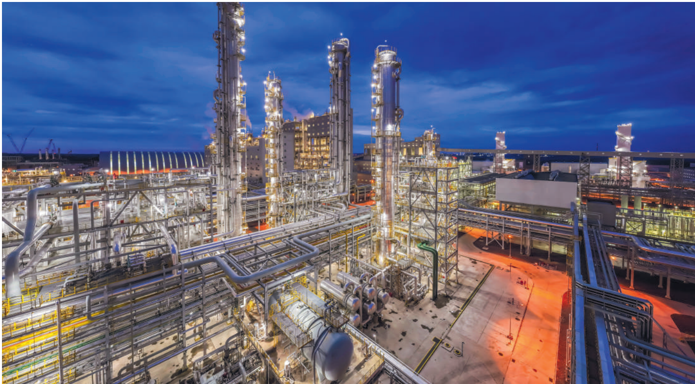
▲ 榆林化工甲醇厂锚定绿色发展目标，全力推动产业转型升级。煤化工与新能源耦合项目一次试车成功，并实现1000小时连续稳定运行，产品质量全程合格；单台日投煤量3000吨单喷嘴水煤浆气化炉平均运行周期达242天；成功实现甲醇合成催化剂国产化，MTO级甲醇年产量连创新高，充分彰显了甲醇厂“科技攻关有我”的责任和担当。图为榆林化工气化甲醇装置现场。 通讯员 刘家硕 摄
