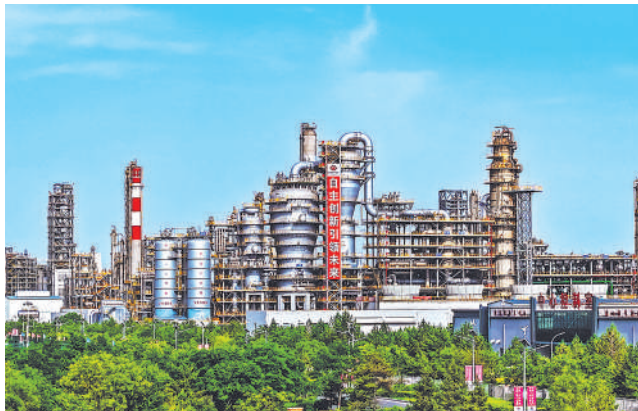
▲ 包头化工积极建设运营世界首套、国家级煤制烯烃示范项目，开创煤基能源化工产业的新途径，奠定了我国现代煤化工产业发展基础。该项目以煤为原料，生产25种聚丙烯和14种聚乙烯树脂产品。图为包头化工甲醇制烯烃厂房。 通讯员 张溪恒 摄
