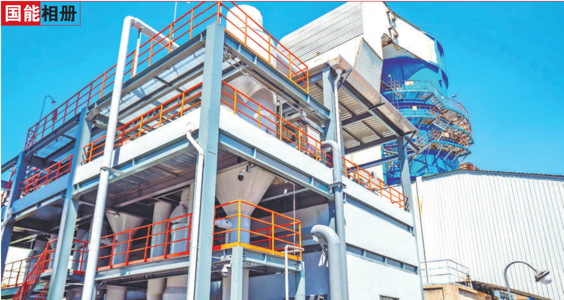
▲9月16日,江西丰城公司脱硫酸废水零排放项目顺利通过168小时试运行。该项目采用“蒸汽闪蒸浓缩+固液分离+主烟道团聚协同高温烟气蒸发干燥”工艺路线,处理四台机组产生的脱硫酸废水。此外,系统自动化程度高,可实现远程监控、一键启动、无人值守,显著提升企业环保治理水平,为打造“无废企业”奠定坚实基础。图为项目配套设施。
