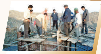
达坂城风电二场风机基础施工。
